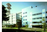
中央システムセンター
