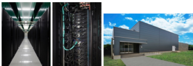
左：ABCI計算ノードラックの一部、中央：冷却システムの一部、右：AIデータセンター棟
