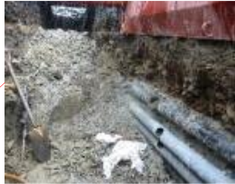
道路の工事（掘削）の様子
