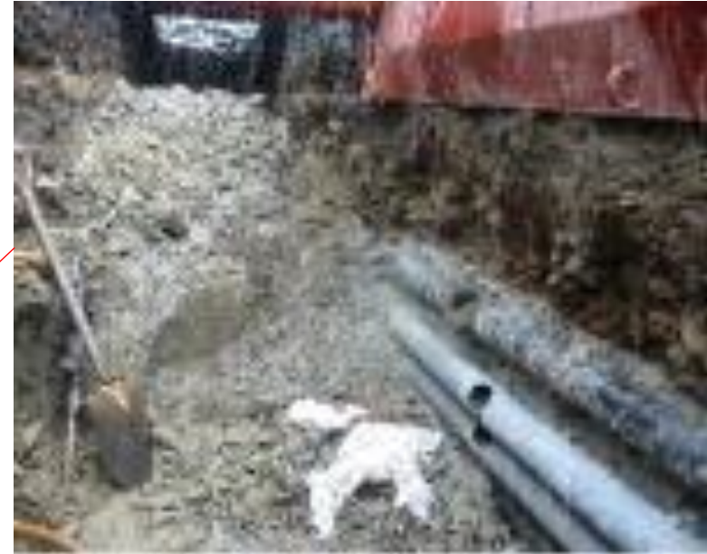
道路の工事（掘削）の様子
