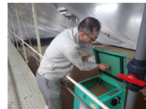
センサーユニットの取付
