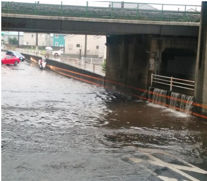
図1. アンダーパス冠水 [5]
