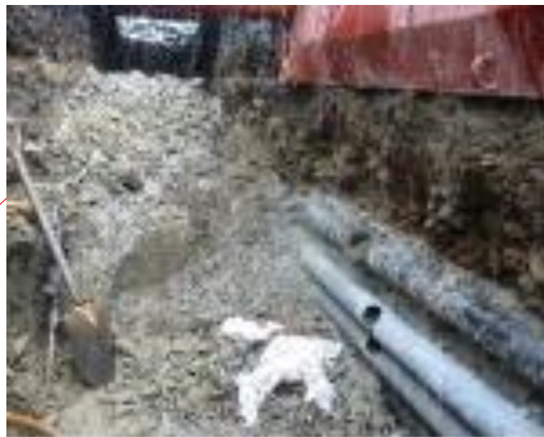
■道路の工事(掘削)の様子
